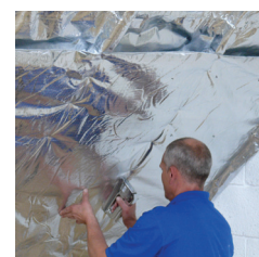
Vgradnja dveh slojev (glej stran 5)
