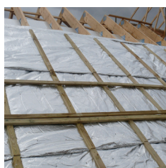
Vgradnja nad škarniki (glej stran 4)
