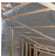
Vgradnja pod škarniki (glej stran 3)
